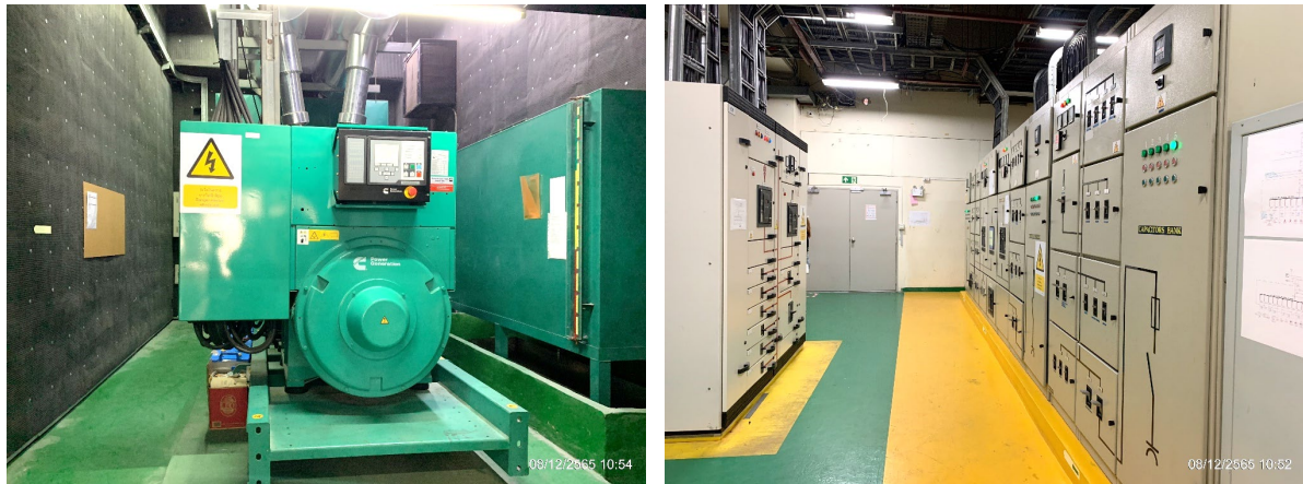
รูปที่ 2-18 เครื่องกำเนิดไฟฟ้าสำรอง
