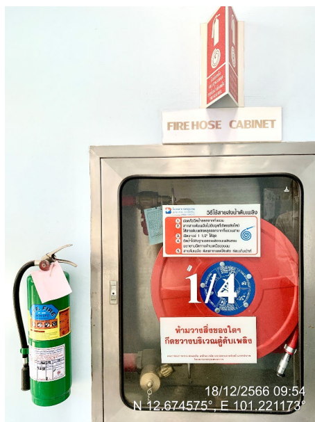
ถังดับเพลิง และตู้เก็บสายฉีดน้ำดับเพลิง พร้อมวิธีการใช้งานภายในอาคารและนอกอาคาร
