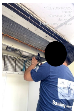
รูปที่ 2-8 เจ้าหน้าที่ทำความสะอาดเครื่องปรับอากาศ
