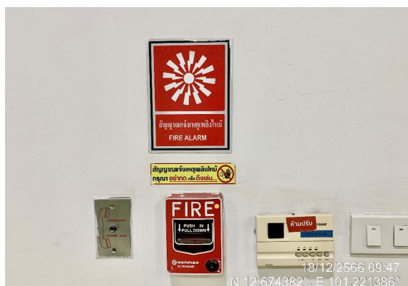
ชุดกดแจ้งเหตุแบบใช้มือดึง Manual Station
