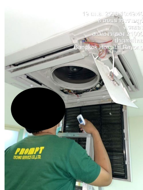
รูปที่ 2-8 เจ้าหน้าที่ทำความสะอาดเครื่องปรับอากาศ
