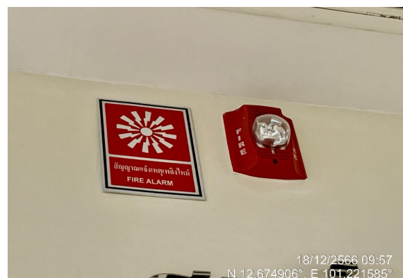
อุปกรณ์ส่งสัญญาณเสียง Strobes and Horns
