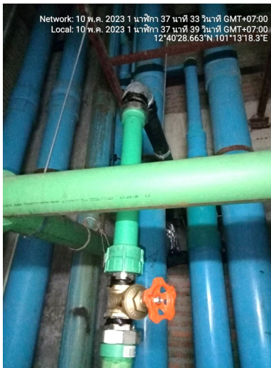
รูปที่ 2-22 การซ่อมแซมระบบจ่ายน้ำประปา
