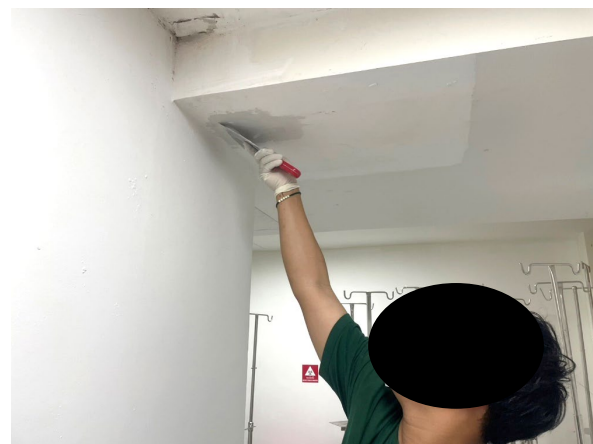
รูปที่ 2-21 การอุดรอยรั่วตามผนัง เพดาน เพื่อไม่ให้สูญเสียความเย็น
