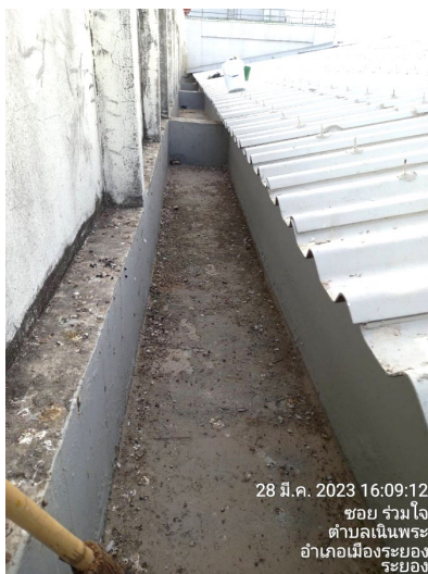
รูปที่ 2-28 เจ้าหน้าที่ตรวจสอบและทำความสะอาดรางระบายน้ำ
